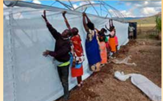
Mit Hilfe der Frauengruppe wird die neue Folie angebracht.
