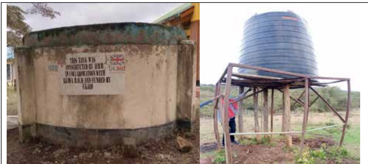
Bild: Wasserbehälter und Tanks, die vom Bohrloch in Baawa beschickt werden
